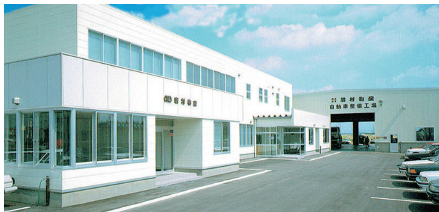
本社 自動車整備工場 新潟県北蒲原郡聖籠町東港7丁目61番12号
