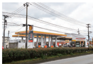
東港給油所 新潟県北蒲原郡聖籠町東港3-6068-24
