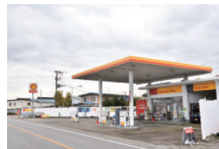
紫雲寺給油所 新潟県新発田市稲荷岡796
